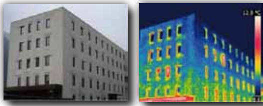
Minőségi hőszigetelő rendszerrel készült épület hőtérképe
