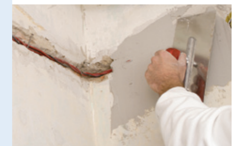
felújítás – hornyok kitöltése
