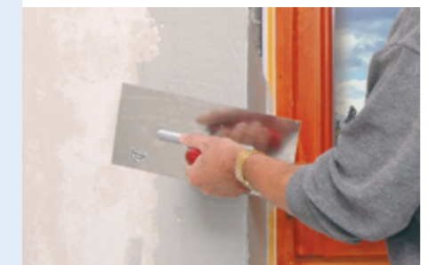
felújítás – nyílászáró csere
