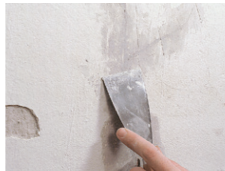
repedések, felületi hibák kitöltése
