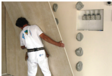
Rigips lap felragasztása falra
