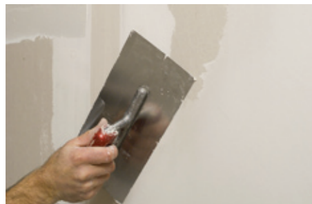
Rigips lapok teljes felületi glettelése
