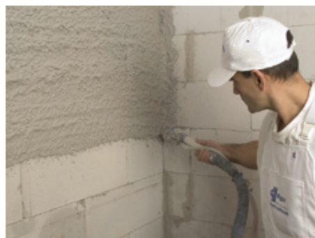
gépi felhordás pórusbeton falra
