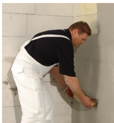
kézi felhordás pórusbeton falra
